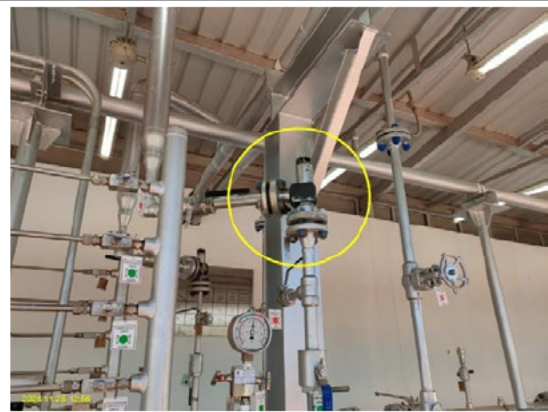
ติดตั้ง Safety & Relief Valve บริเวณอาคารควบคุมความดันและวัดปริมาตรก๊าซ (Metering Room) จำนวน 2 ตัว
