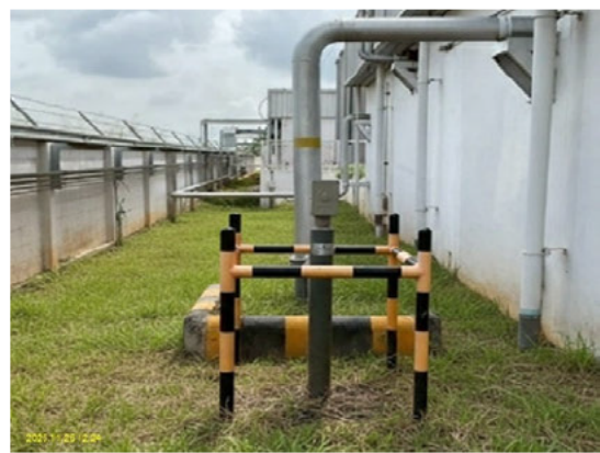
ติดตั้งตัวป้องกันสนิมในท่อส่งก๊าซธรรมชาติ เพื่อป้องกันท่อจากการกัดกร่อน (Corrosion)
