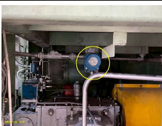
ติดตั้งเครื่องส่งสัญญาณเมื่อเกิดก๊าซรั่ว (Gas Detector) (ต่อ)
