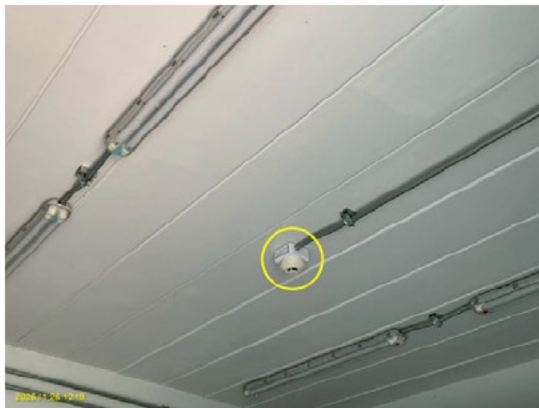
ติดตั้งอุปกรณ์ตรวจจับควันไฟ (Smoke Detector) ไว้บริเวณห้องควบคุมระบบไฟฟ้า
