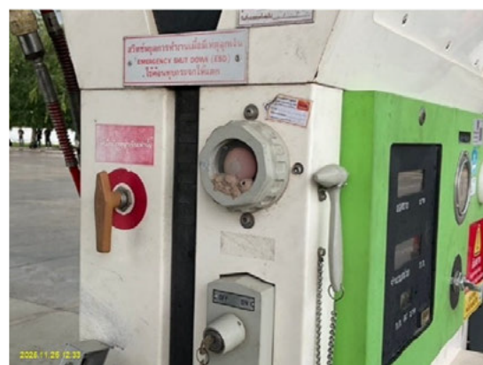
ติดตั้งสวิตช์หยุดการทำงานเมื่อมีเหตุฉุกเฉินไว้บริเวณ หัวจ่ายก๊าซธรรมชาติ และบริเวณตู้จ่ายก๊าซธรรมชาติ
