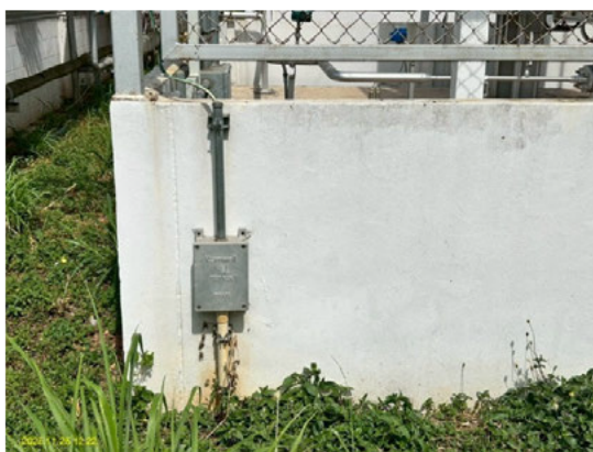
ติดตั้งสายดินบริเวณที่มีการใช้งานของอุปกรณ์ไฟฟ้า เพื่อป้องกันอันตรายจากกรณีที่มีกระแสไฟฟ้ารั่ว
