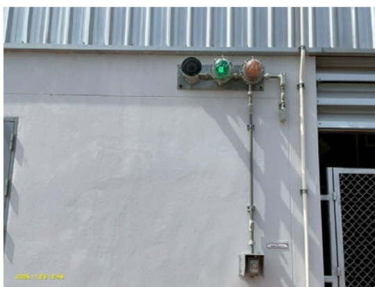
ติดตั้งระบบสัญญาณเสียง-สัญญาณไฟแจ้งเตือนเหตุฉุกเฉินไว้บริเวณอาคาร Compressor
