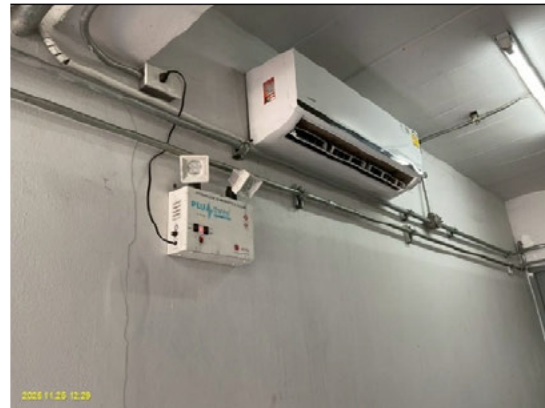
ติดตั้งระบบไฟฟ้าแสงสว่างฉุกเฉิน (Emergency Light System) ไว้บริเวณห้องควบคุมระบบไฟฟ้า
