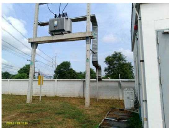
ติดตั้งระบบแหล่งจ่ายไฟฟ้า (หม้อแปลงไฟฟ้า)
