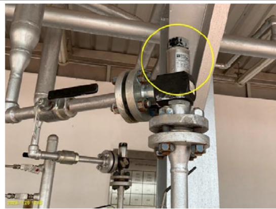
ติดตั้ง Safety & Relief Valve บริเวณอาคารควบคุมความดันและวัดปริมาตรก๊าซ (Metering Room) จำนวน 2 ตัว
